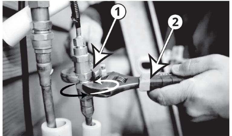
**IMPORTANT :** Étant donné que le raccord fonctionne avec des bagues de serrage, il peut y avoir une fuite si vous déconnectez et reconnectez les tuyaux. Cela annule également la garantie.
