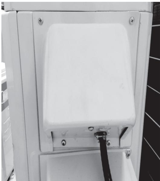
2. Retirez l'écrou de retenue du câble DIYPRO® que vous avez fait passer par le trou mural plus tôt dans l'installation.
